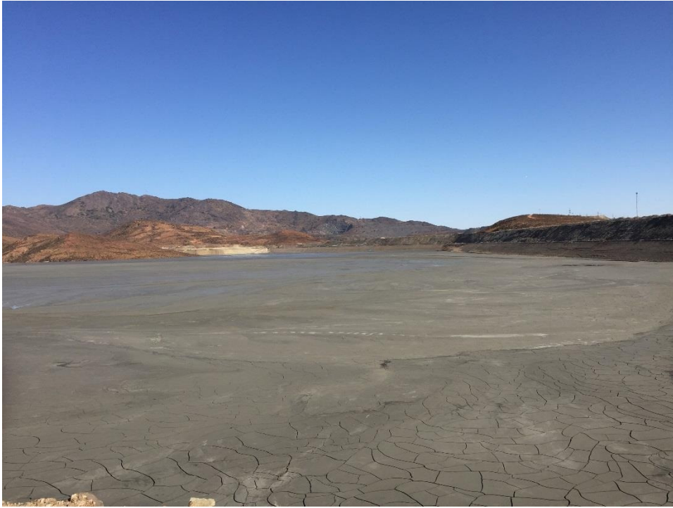
Fotografía 19: Cubeta – vista hacia el Nor Poniente
