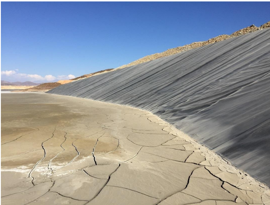
Fotografía 2: Muro Sur - Talud Aguas Arriba, Impermeabilización de Talud Aguas Arriba
