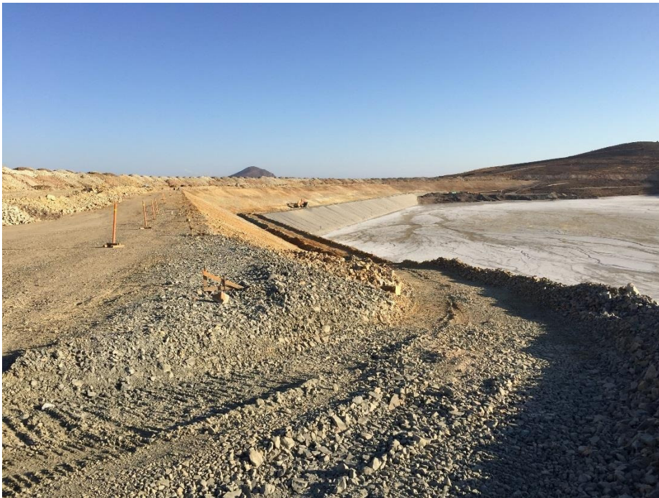
Fotografía 14: Muro Oriente Sur – Vista hacia el Sur
