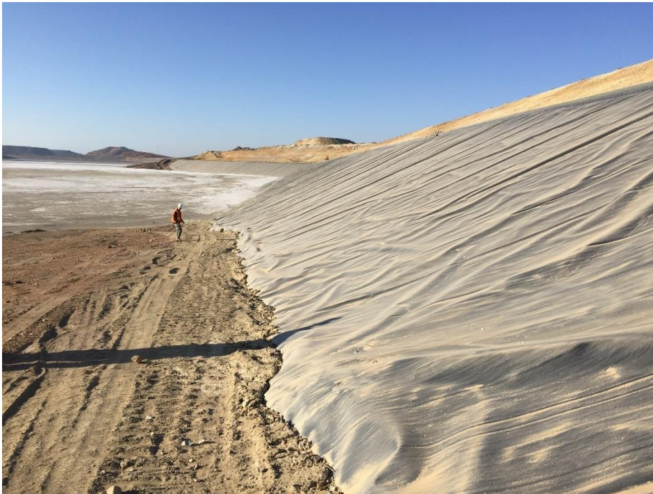
Fotografía 6: Muro Oriente Sur - Estribo Sur
