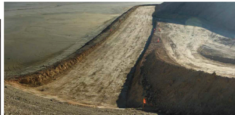
2018.05.15 BS: Sello de fundación reparación PL El. 1141,00 msnm, BS
