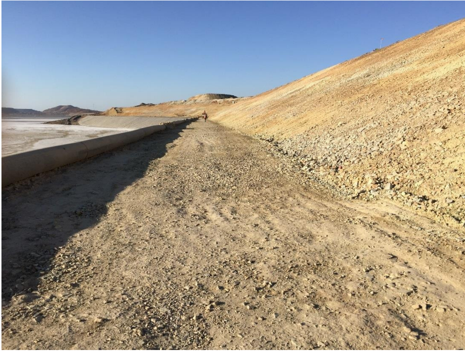
Fotografía 9: Muro Oriente Sur – Vista hacia el Norte
