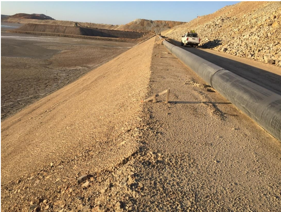
Fotografía 16: Muro Oriente –Vista hacia el Norte
