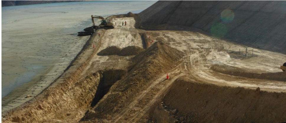
Foto 8-5: BS, Exploración de Talud, Pl. 1.141 msnm, 2018.05.17
