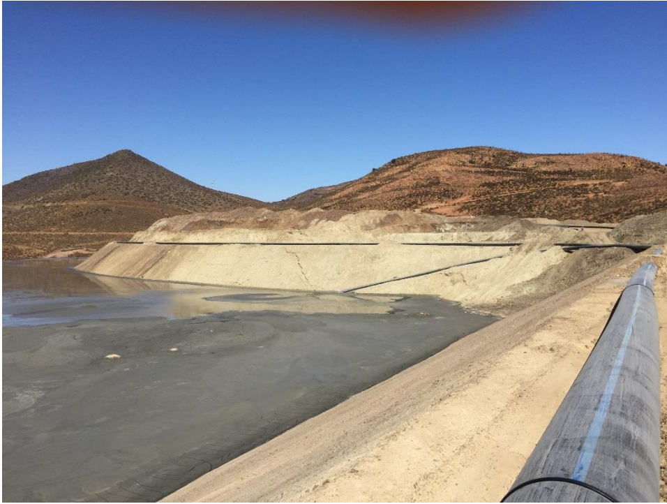
Fotografía 27: MN y acopio de Relaves UV – Playa de Relaves Húmeda por reciente Operación de Descarga
