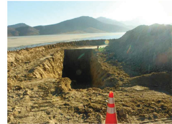
2018.05.16 BS: Calicata sector poniente reparación PL El. 1141,00 msnm, BS
