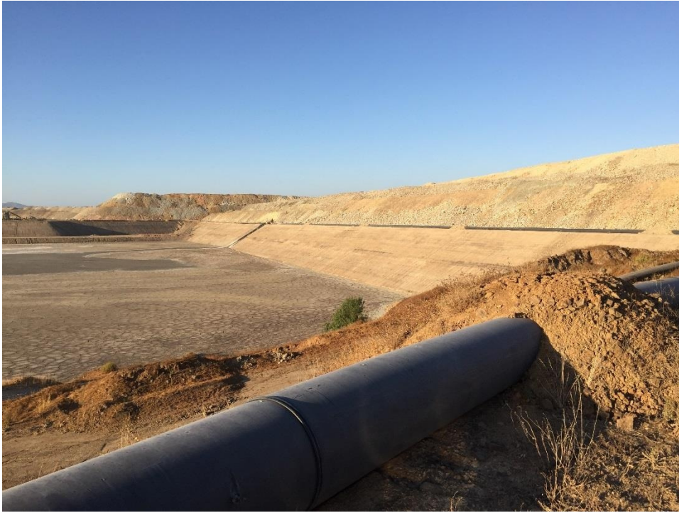
Fotografía 15: Muro Oriente Vista hacia el Nor Oriente
