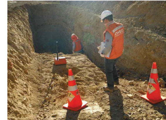
2018.05.14 BS: Calicata sector oriente reparación PL El. 1141,00 msnm, BS
