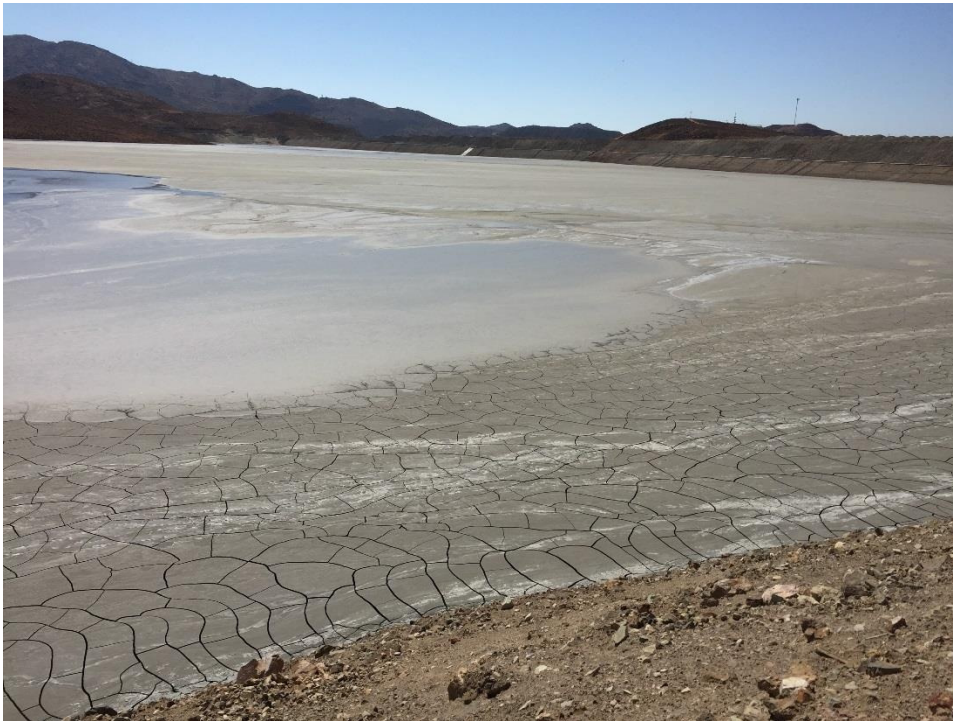
Fotografía 36: BS – Playas de Relaves Húmedas por Operación reciente de la Descarga Rebose
