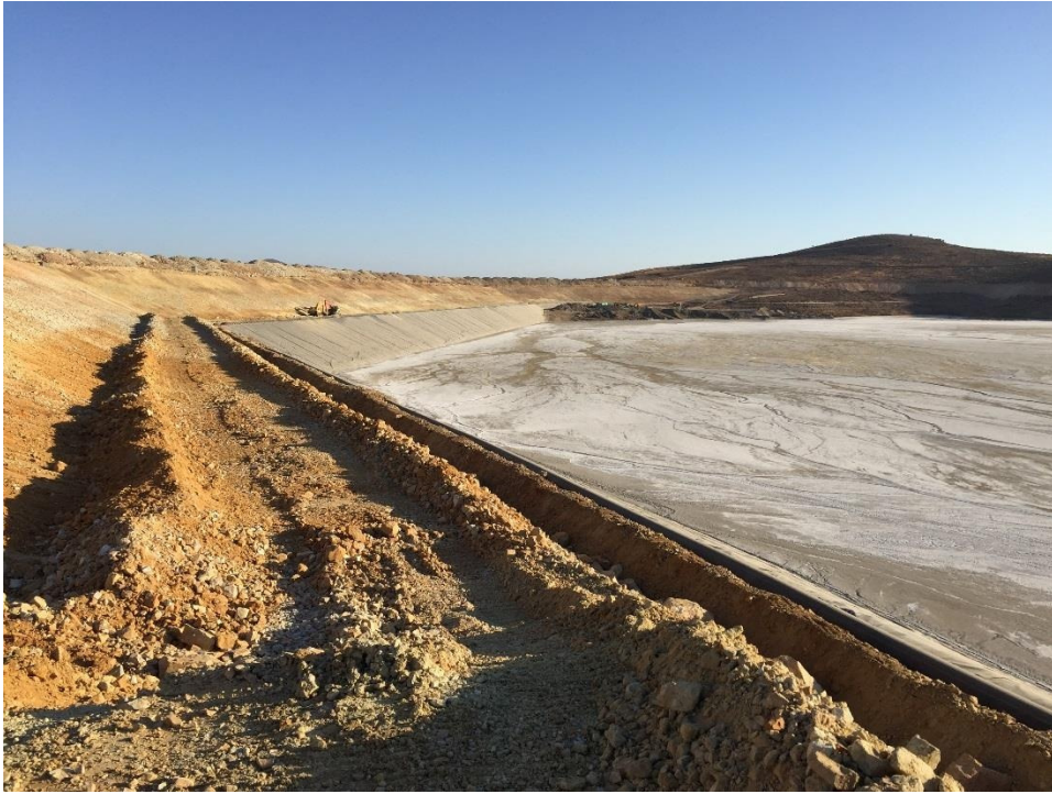
Fotografía 13: Muro Oriente Sur – Vista hacia el Sur
