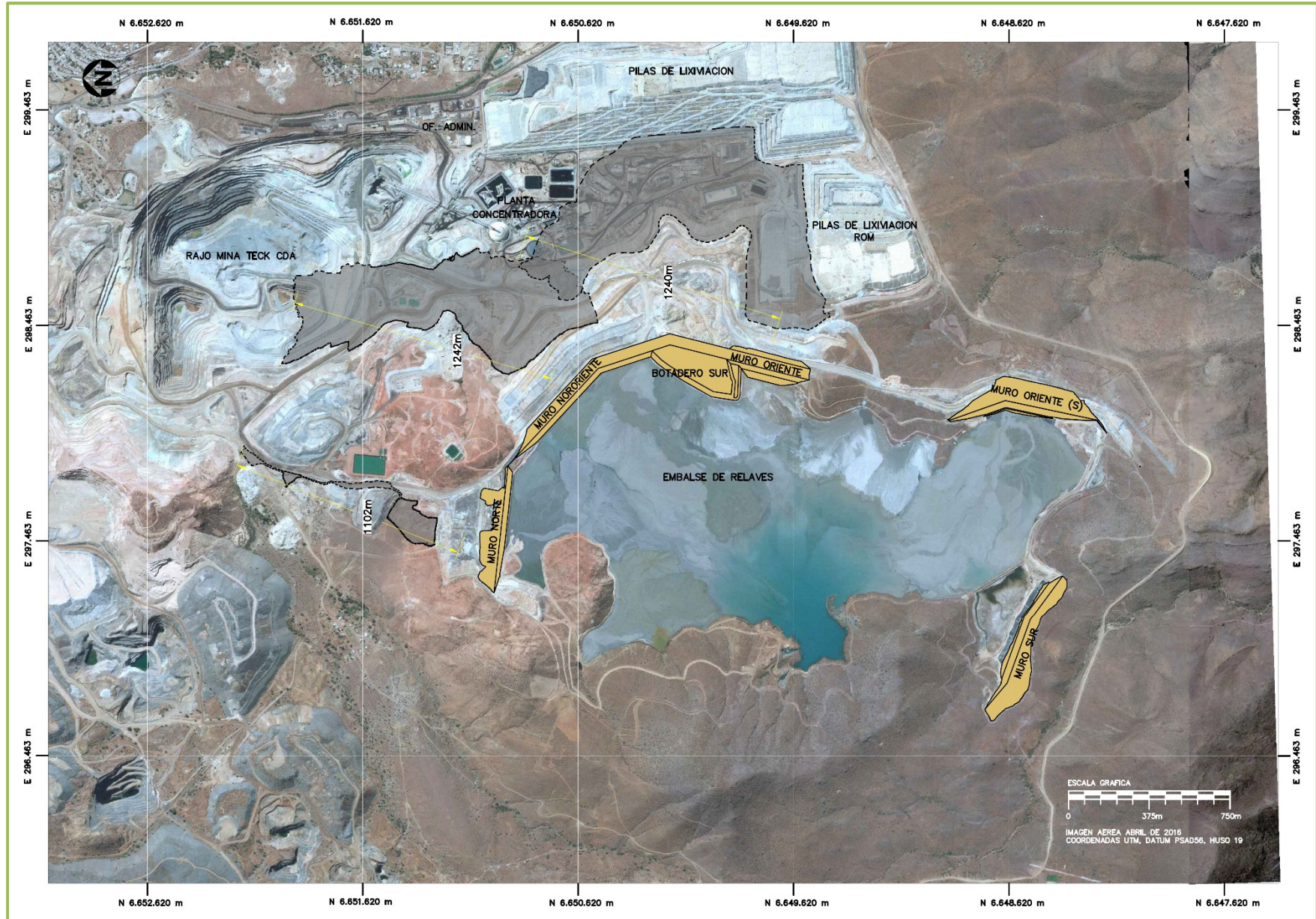
Figura 8-8: Superficie afectada por ruptura de los muros Etapa 3, 2017.03.14 (ref. estudio de Distancia Peligrosa, AmecFW)
