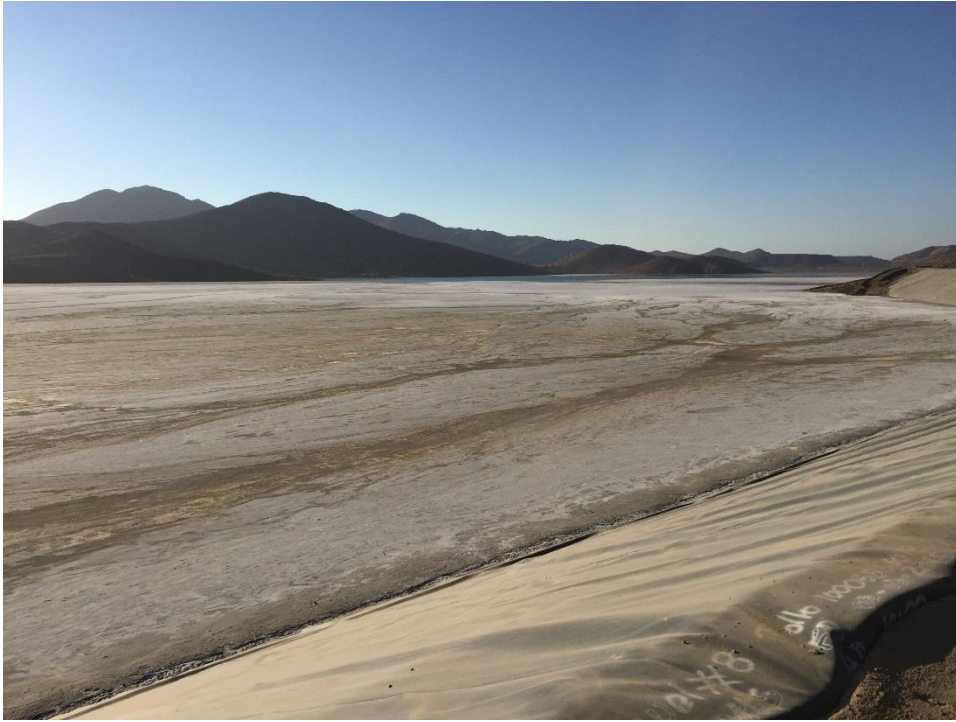
Fotografía 11: Cubeta Vista hacia el Nor Poniente
