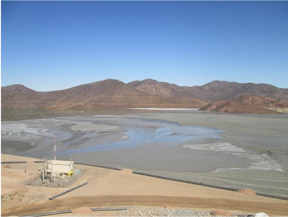
Fotografía 41: BS – Playas de Relaves Húmedas por Operación reciente de la Descarga Rebose
