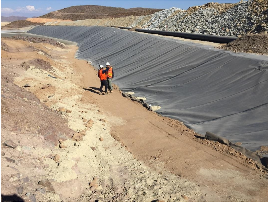
Fotografía 1: Muro Sur - Estribo Poniente
