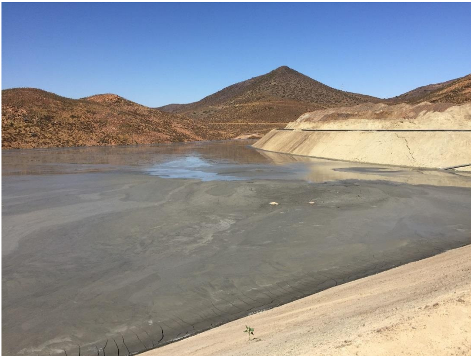
Fotografía 28: MN y Acopio de Relaves UV – Playa de Relaves Húmeda por reciente Operación de Descarga
