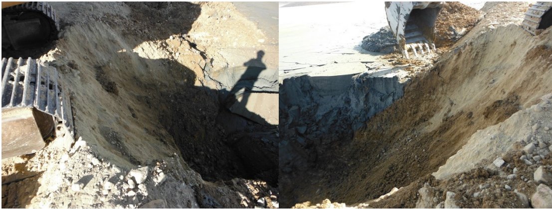
Foto 8-6: BS, Exploración de talud en contacto con playa de relaves, 2018.05.17
