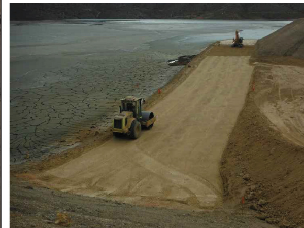
2018.05.28 BS: Construcción capa #2 reparación PL El. 1141,00 msnm, BS
