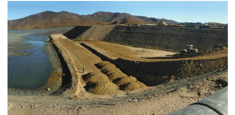
2018.05.23 BS: Construcción capa #1 reparación PL El. 1141,00 msnm, BS
