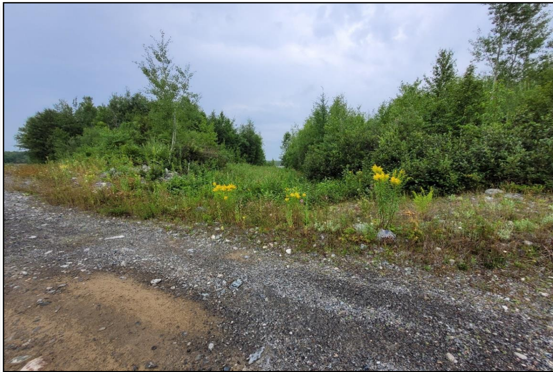
Photo 4 : Deuxième déversoir d'urgence, parc à résidus. Vue de la végétation dans le canal aval.
