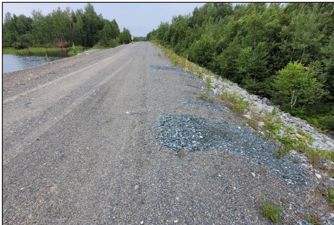
Photo 6 : Digue 1E – Preuve de travaux d'entretien dans les sillons d'érosion sur la crête de la digue.
