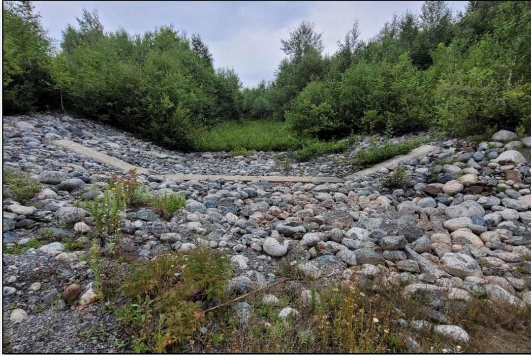
Photo 3 : Deuxième déversoir d'urgence, parc à résidus. Vue du seuil en béton, et de la végétation dans le canal amont.
