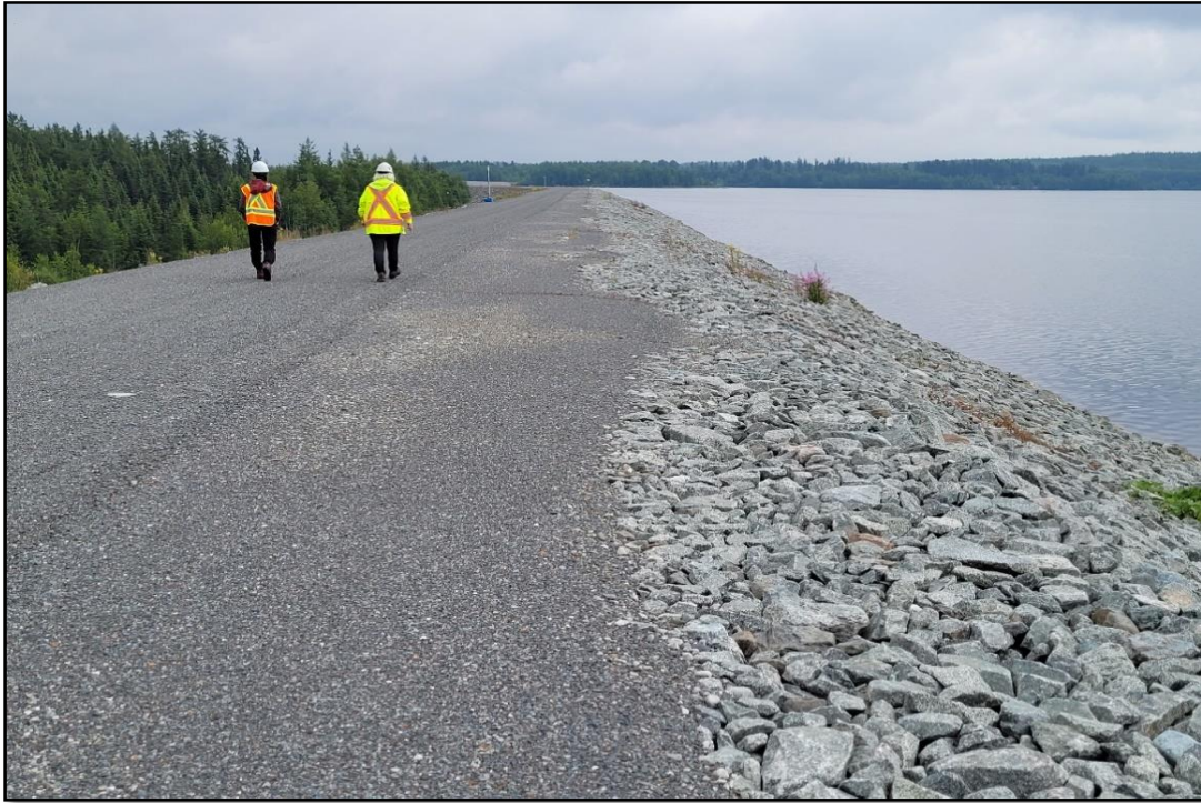
Photo 1 : Digue 1D – Vue de la pente amont avec enrochement remplacé.
