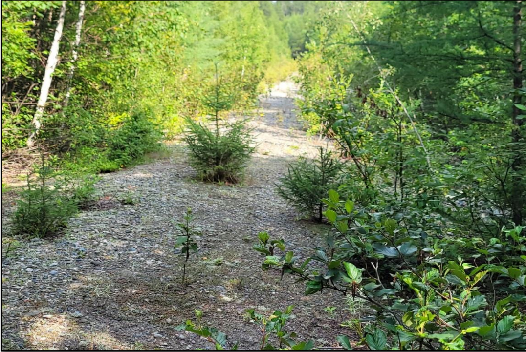
Photo 11 : Digue 4A qui ne retient pas d'eau actuellement. À noter : la végétation limitée sur les pentes et la crête.
