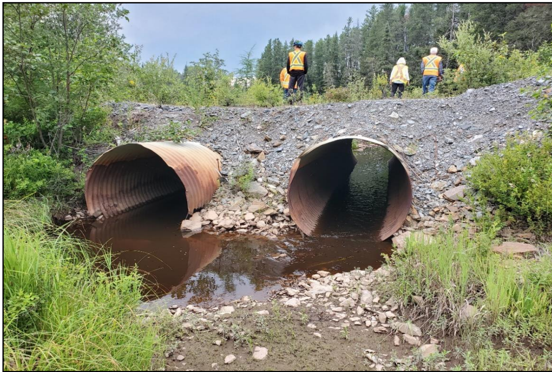
Photo 10 : Ponceaux sur le ruisseau sans nom, au nord-ouest du parc à résidus. Les barrages de castor ne se sont pas reproduits depuis 2019.
