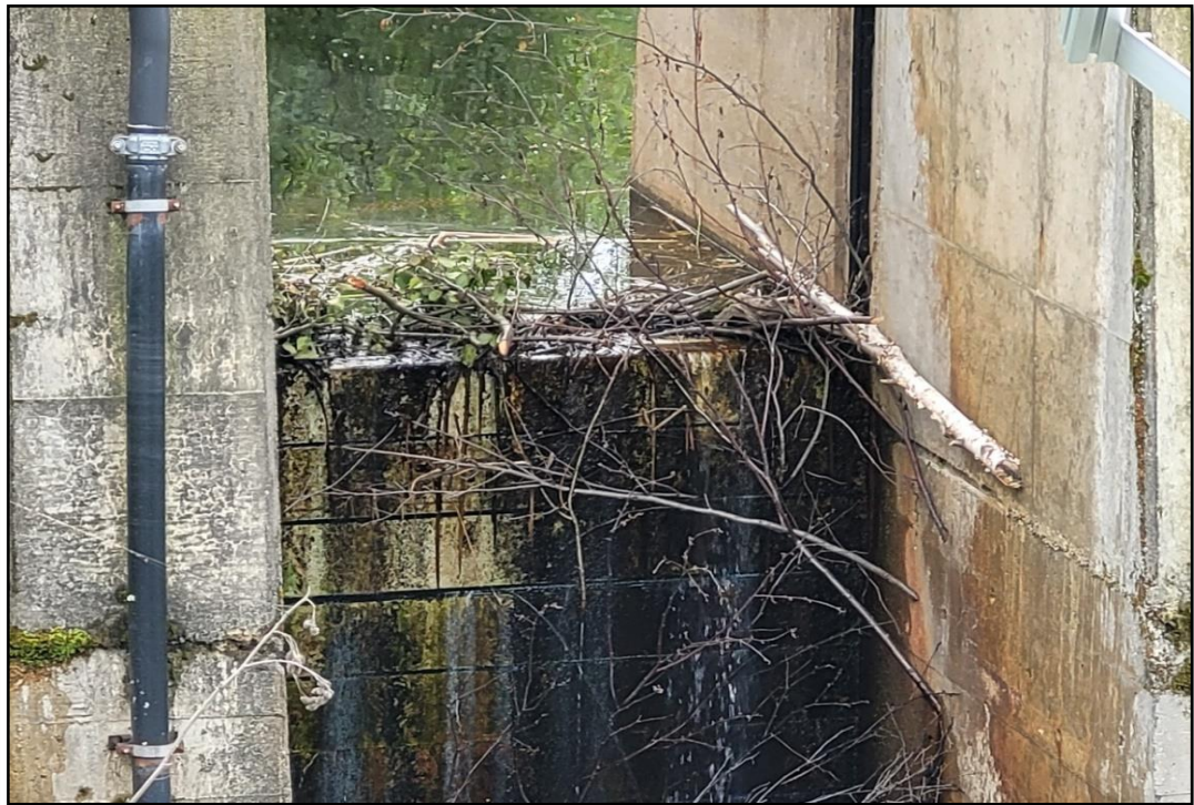
Photo 12 : Digue 4B – Accumulation de débris prouvant l'activité de castors dans le déversoir. L'enlèvement ponctuel des débris dans le déversoir doit être prévu.
