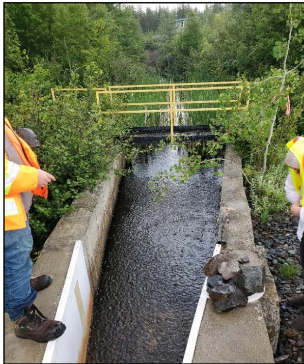
Photo 14 : Canal exutoire du site. À noter : la végétation dans le canal.
