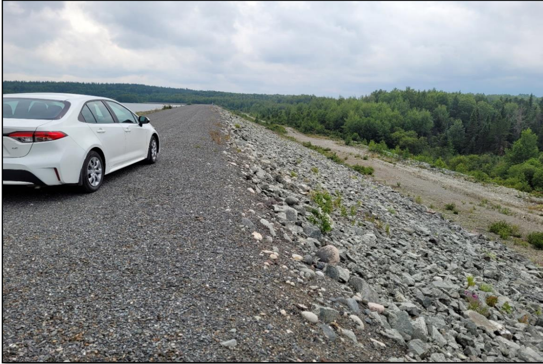
Photo 7 : Digue 1C – Vue de la crête démontrant la flore au pied de la digue.
